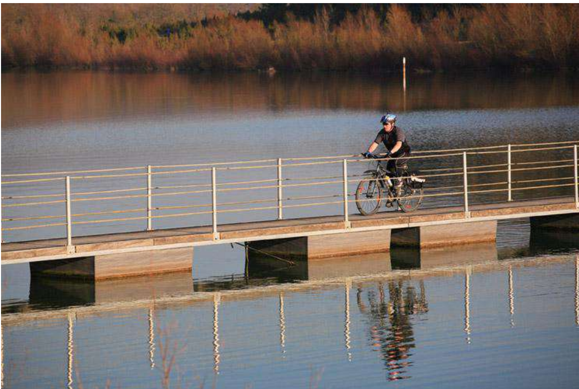
Fig. 00. Pasarela ciclable sobre pantalanen en el vecino pantano de Ullibarri-Gamboa, como posible solución técnica para carreteras y caminos tradicionales inundados (fuente: https://ullibbarri-gamboa.araba.eus/es/memoria-historica-del-embalse )
