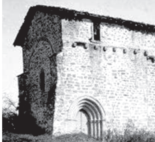
Fig. 00.- Detalle de una fotografía anterior a 1958, en la que puede apreciarse el tramo desaparecido de la nave con la portada en su posición original (sur), los canes hoy desaparecidos y el recrecido para cubierta de madera antes citado. Se ve que el muro oeste, que cierra la nave a los pies, no es tal, sino el cegado de un arco perpiaño, apuntado. Tendría, pues, continuidad hacia poniente, seguramente con otro tramo de planta cuadrada similar al que aparece en la fotografía, si atendemos a lo que es común en este tipo de iglesias. Fuente: Gerardo López de Guereñu
