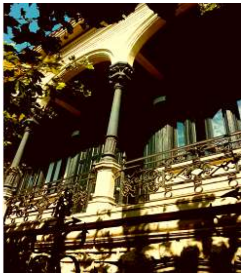
Fig. 00. Edificio protoindustrializado (fuente: foto Ander de la Fuente)
