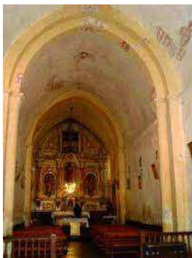
Fig. 00.- Bóveda apuntada, arcos perpiaños y muros de carga, con cabecera de planta cuadrada ligeramente más baja y dos tramos de nave en la iglesia de San Andrés Apóstol de Legarda. Fuente: AKOBE, Patrimonio Cultural en Álava
