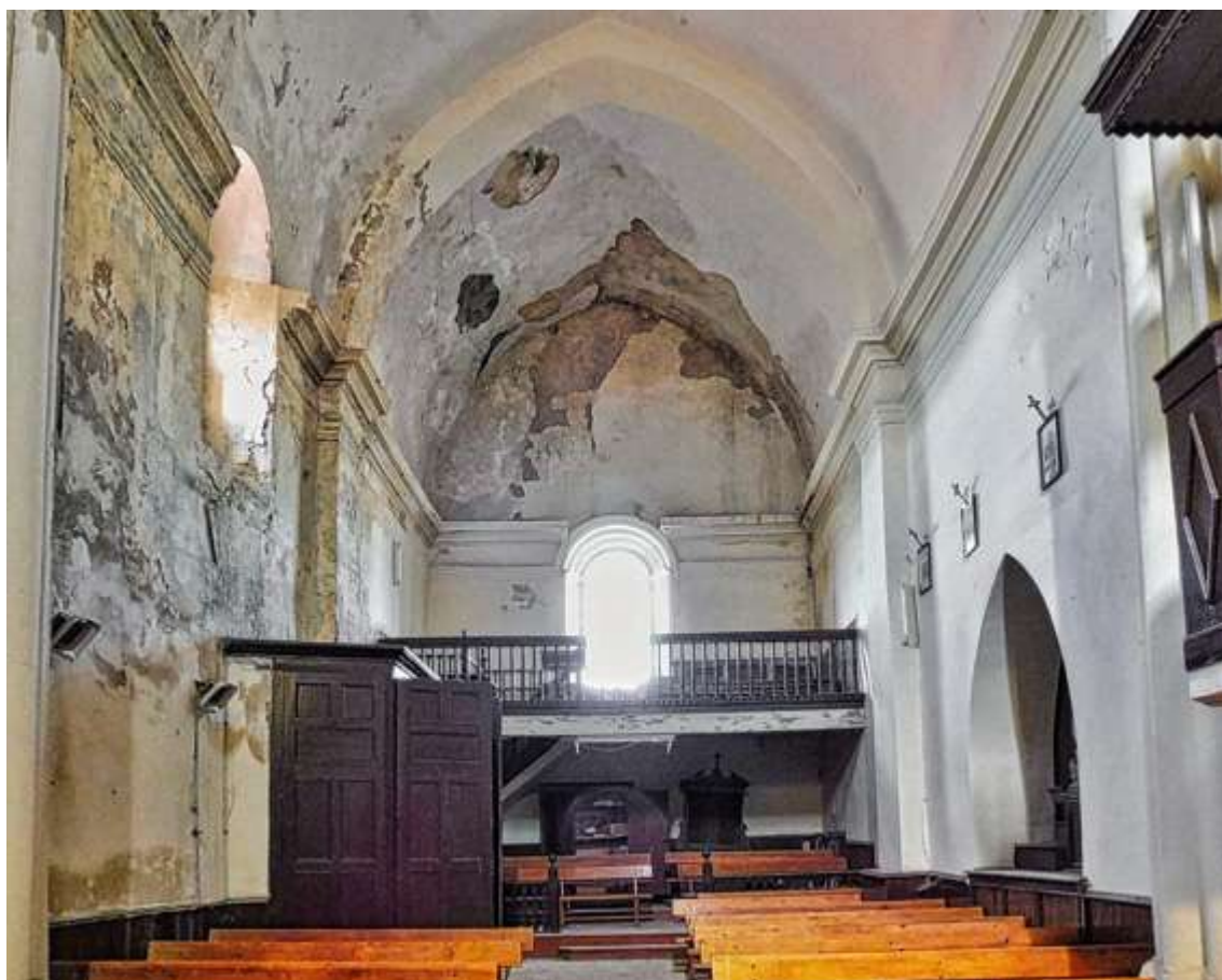
Fig. 00.- Bóveda apuntada, arcos perpiaños y muros de carga en la iglesia de San Pedro de Belunza. Fuente: @RomanicoEspana
