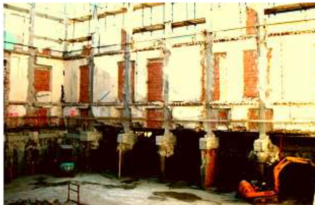
Fig. 00. Jet grouting y façadism sobre un mismo edificio antiguo: la fachada como excusa (fuente: http://www.geosistema.it/ )
