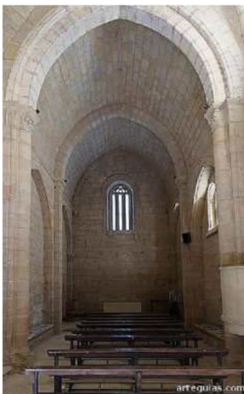
Fig. 00.- Arcos perpiaños y bóveda apuntada en la iglesia de Santa María de la Sorejana, del siglo XIII, en Cuzcurrita del Río Tirón (La Rioja). Fuente: Arteguías
