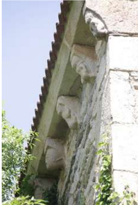
Fig. 00.- Cornisa y canecillos de la cabecera de la iglesia de Santa Ana de Goain, sobre mampostería concertada con esquineros de sillarejo. Fuente: Ibon Sáenz de Olazagoitia
