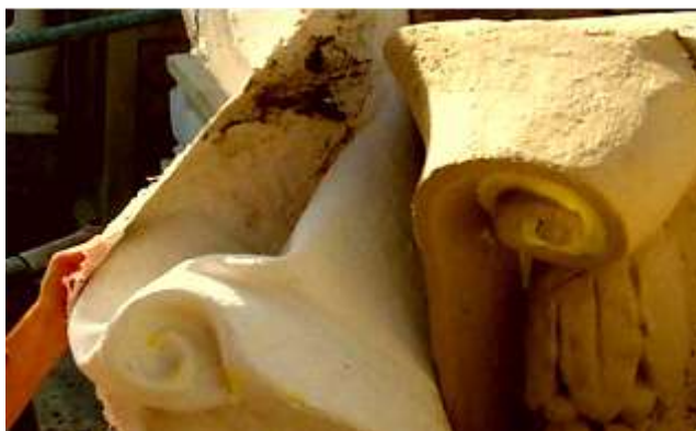
Fig. 00. Moldes de silicona para reproducir elementos decorados (fuente: http://www.alfredobueno-moldes.com/ )
