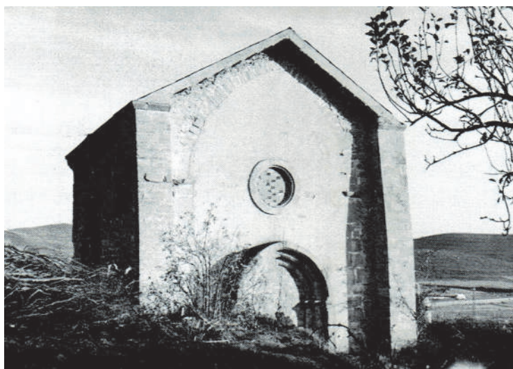
Fig. 00.- La cabecera de la iglesia de Goiaín hacia 1985, tras las obras de 1958. Véase el torpe muro de cegado del arco perpiño y la portada del sur toscamente recolocada en la nueva "fachada" oeste con óculo. Fuente: Victorino Palacios
