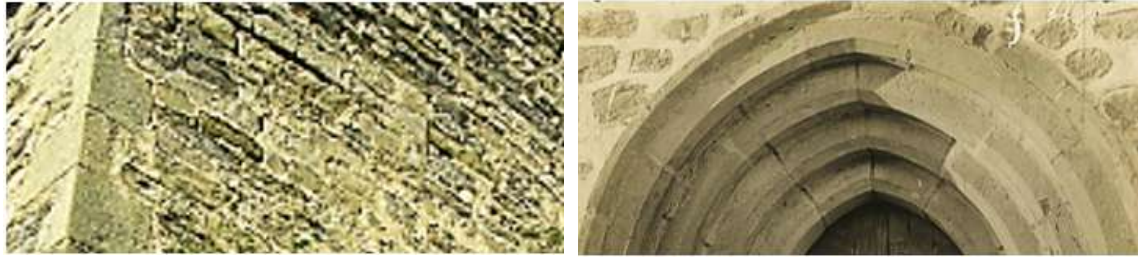
Fig. 00.- Detalle de mampostería concertada en la cabecera de la iglesia de Santa Ana, y del "aparejo gótico" de la nave desaparecida. Fuente: Ibon Sáenz de Olazagoitia (cabecera) y Lorenzo Elorza (nave)
